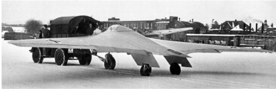
Un avión a reacción tipo ala delta Horten Ho-IX en la primavera de 1944
